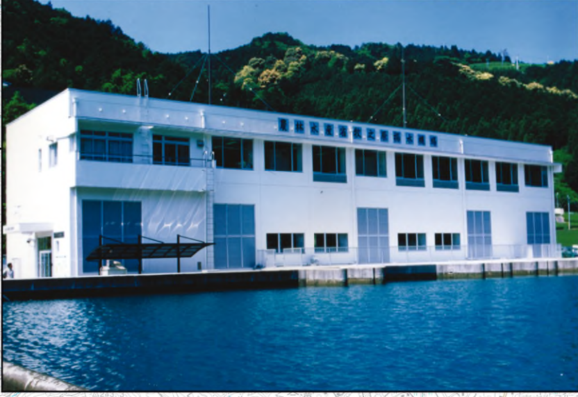
国営揚水機場
